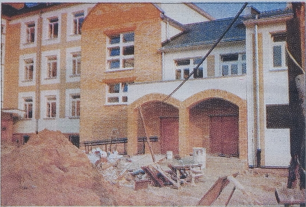
Budynek hali jeszcze podczas ostatnich prac wykończeniowych
