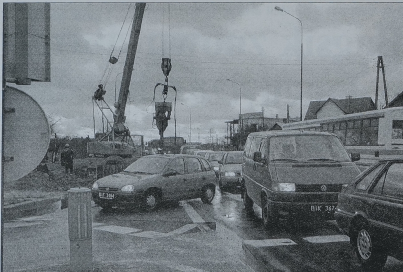
Kierowcy jadąc od ul. Popiełuszki przez miasto będą musieli być bardzo cierpliwi – budowa kanału deszczowego stała się przyczyną powstania drogowego korku w pobliżu wjazdu do tunelu
