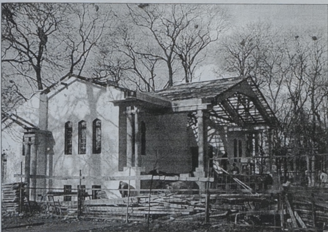
Wiosną przyszłego roku ma odbyć się pierwsza impreza w nowej suwalskiej muszli koncertowej. W tej chwili trwają intensywne prace przy jej budowie. Inwestycję w Parku Konstytucji 3 Maja finansuje miasto, a realizuje firma Konsbud. Powstanie duży obiekt z ruchomą sceną i obszernym zapleczem. Umożliwi to organizowanie koncertów nie tylko w lecie.
