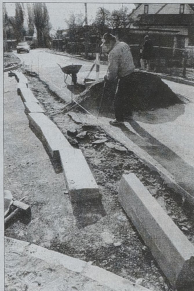
Pracownicy PEUM ułożą cały asfalt na ul. Wiatrakowej. Zakorńczenie prac na ul. Ukośnej nastąpi wiosną.
