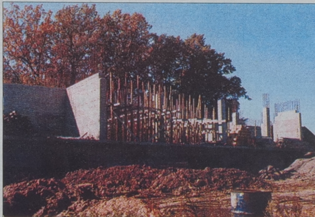
Biurowiec „Bial-Budu” na rogu ulic Wasilkowskiej i 27 Lipca: wyżej – wyniosła wizja architektów; niżej – obecny stan na placu budowy
