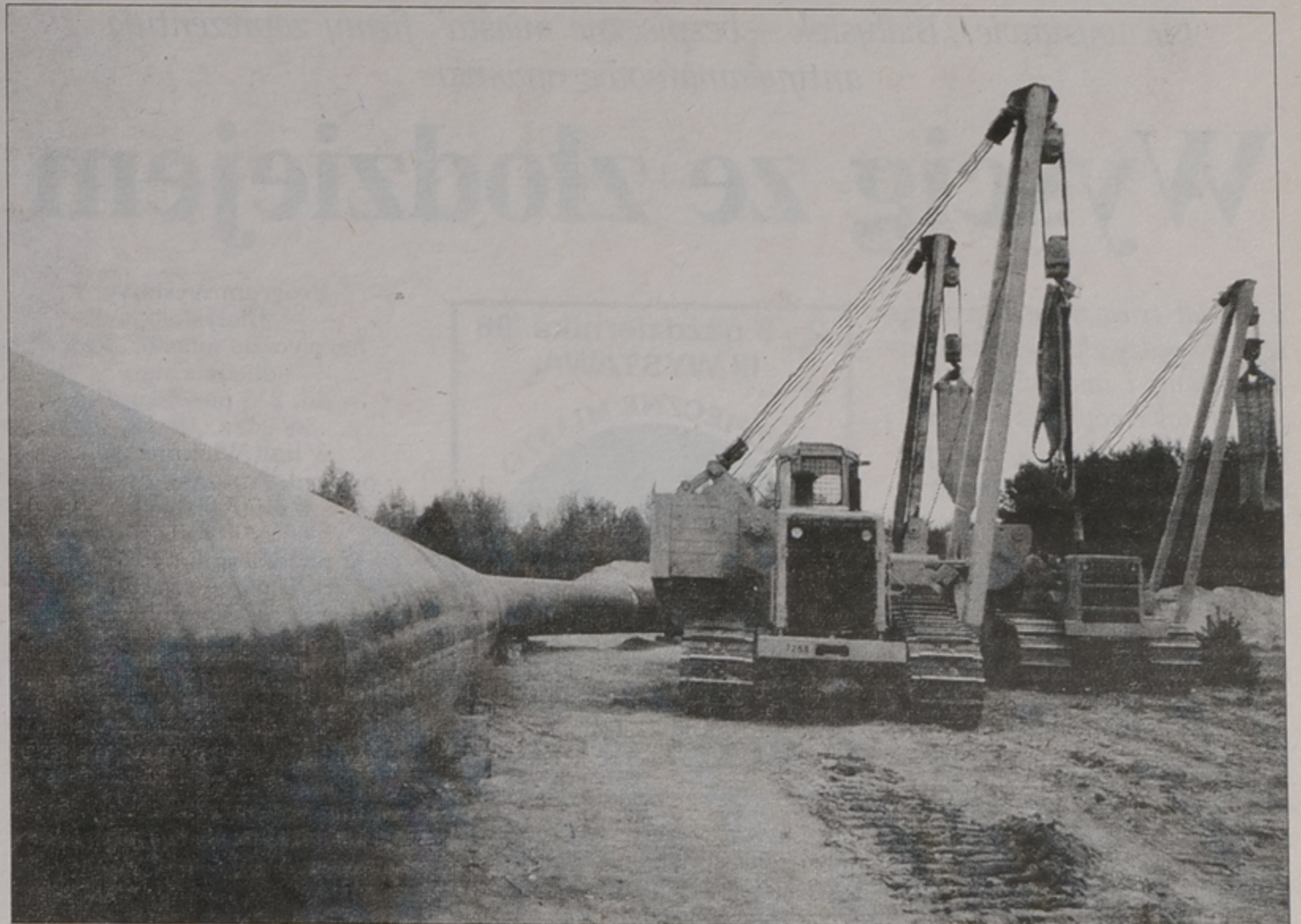
90-tonowe „boczniki” przy pracy
