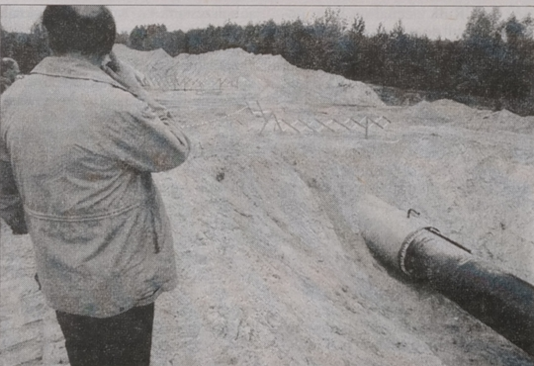
Tak wygląda gazociąg już po zasypianiu, zewnętrzna rura widoczna na zdjęciu ma chronić rurę zasadniczą
