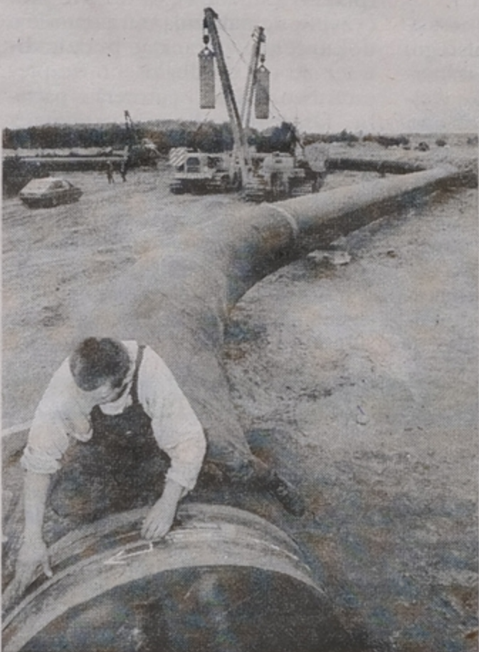
Sprawdzanie styków wielkiej rury
