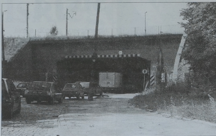
Nawet teraz przed tunelem ustawiają się kolejki samochodów. Strach pomyśleć, co będzie się działo w czasie remontu.
