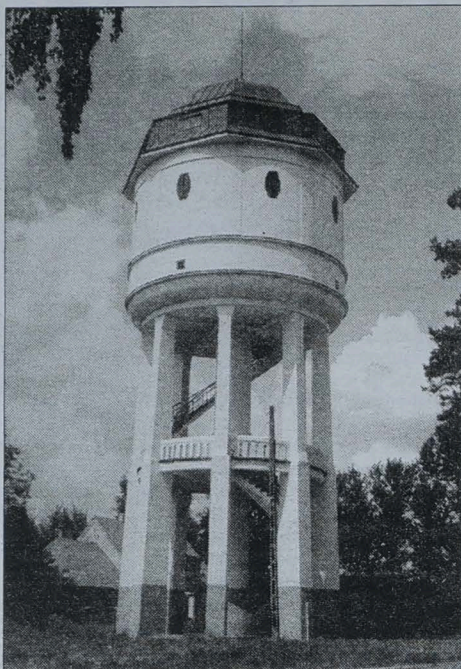
Stacja uzdatniania wody na Pietraszach zostanie zmodernizowana najpóźniej do 2005 r.
