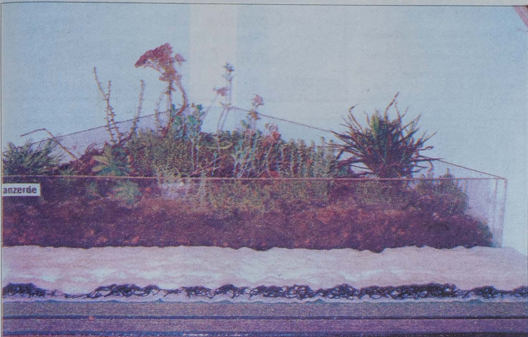
Tak w przekroju wyglądają kolejne warstwy, które należy ułożyć na dachu, aby móc stworzyć żywą zieloną pokrywę
