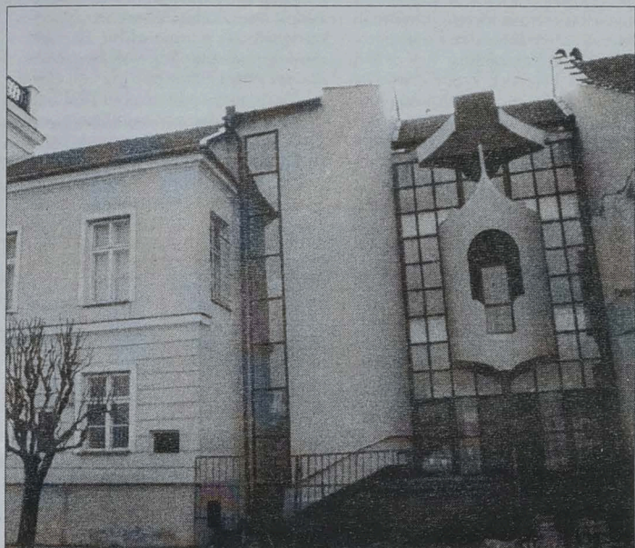
Oryginalna elewacja frontowa nowego skrzydła łomżyńskiego Ratusza, autorstwa prof. Jerzego Ulmana, ożywia architekturę Starego Rynku
