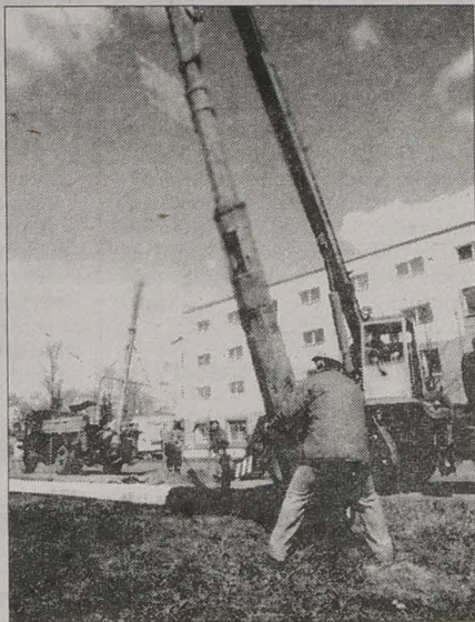
Oprawy wymieniono lub ustawiono na nowo razem z całym latarniami m.in. przy ul. Bran- nickiego
