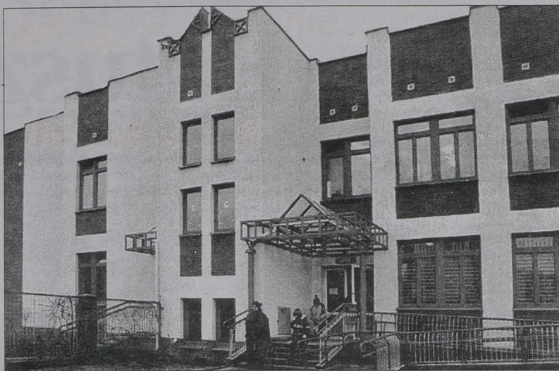
Już wkrótce dotychczas istniejący budynek szkoły zostanie rozbudowany
