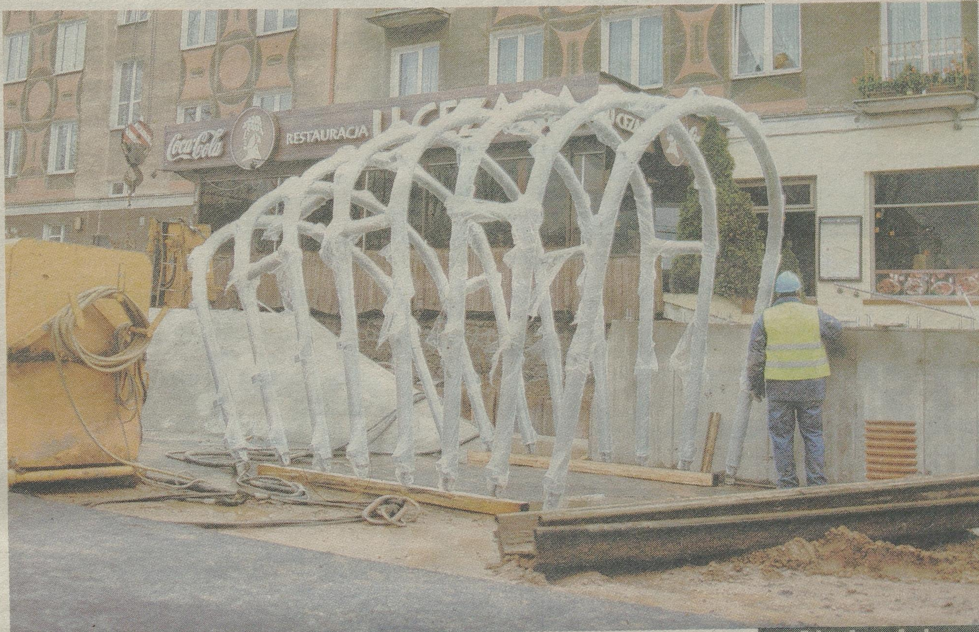
Na skrzyżowaniu al. Piłsudskiego i ul. Sienkiewicza pojawiły się już metalowe konstrukcje, które będą osłaniały wejścia do windy, czy przejścia podziemnego
