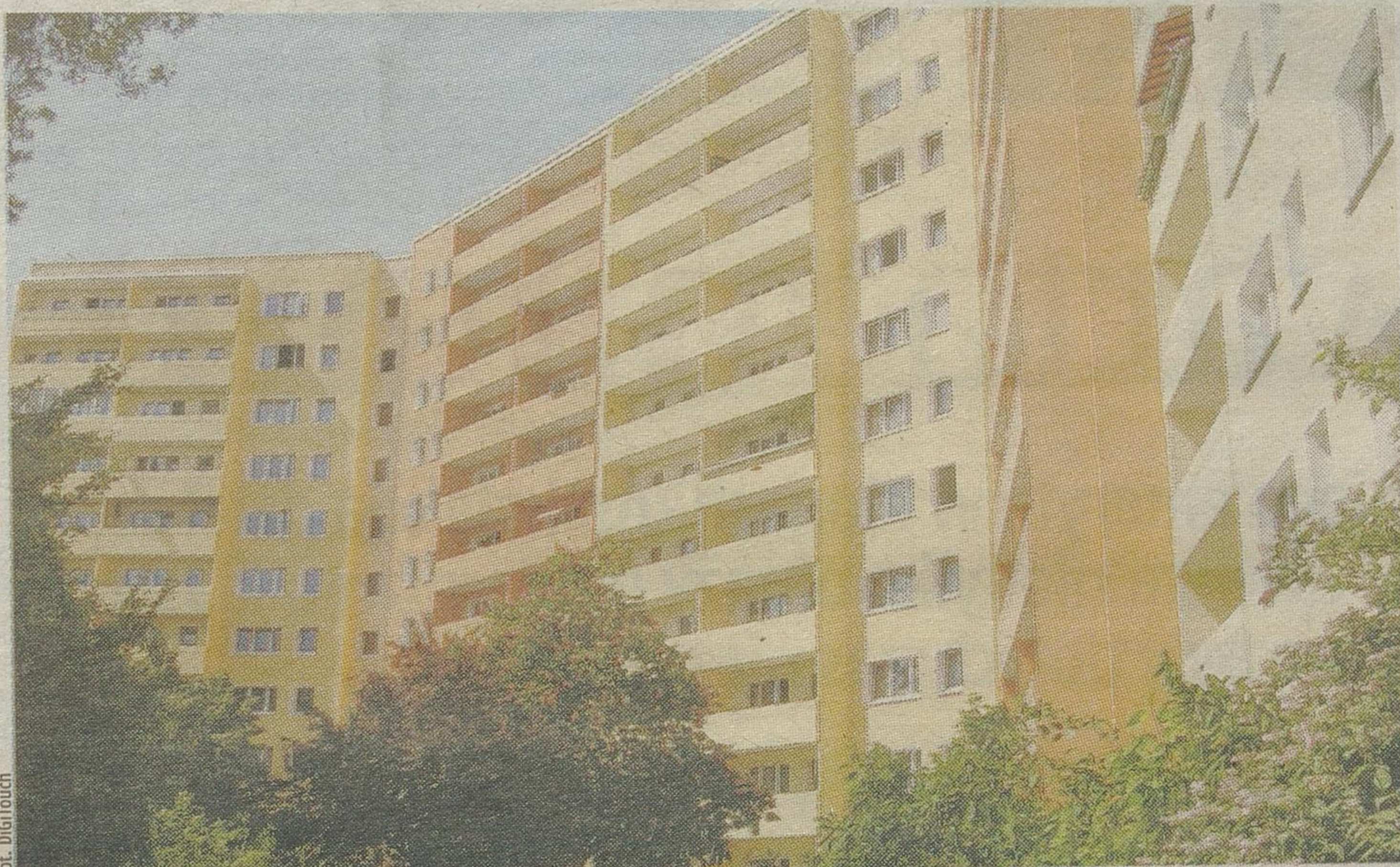
Dobrze przeprowadzona termomodernizacja pozwala obniżyć koszty ogrzewania budynków - również tych najbardziej energochłonnych, mając 50 lat i więcej
