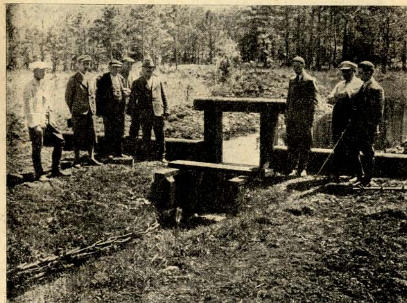
Rów osuszająco-nawadniający w Chłopczech w pow. rudeckim, wykonany na łakach pod kierownictwem Biura Melioracyjnego Lwowskiej Izby Rolniczej.
