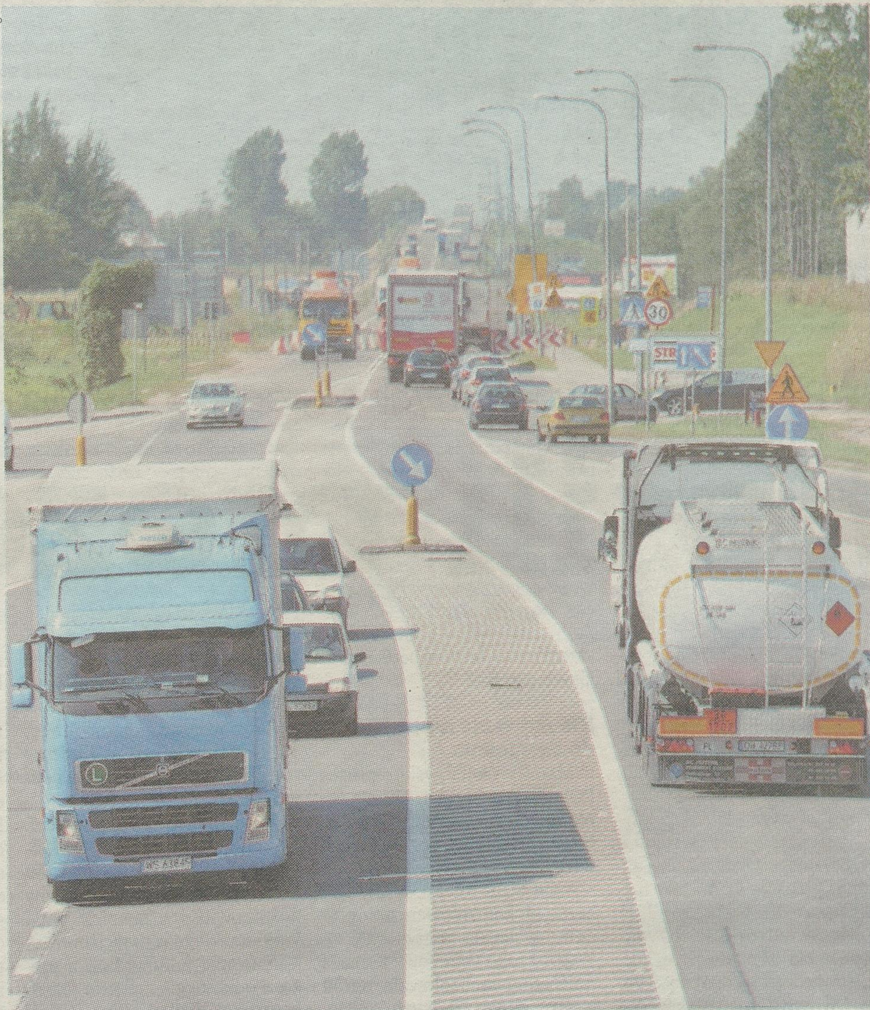
Przebudowa ul. Kleeberga będzie kosztować 105 mln zł
