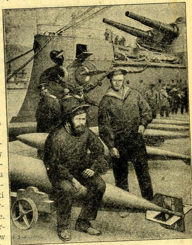
TORPEDY, czyli podłużne (kształtu ryby) naboje wybuchowe, używane w wojnie morskiej. Wystrzelona z osobnej armaty torpeda płynie sama ku okrętowi nieprzyjacielskiemu i uderzając dziobem w bok okrętu wybucha z groźnym skutkiem.
