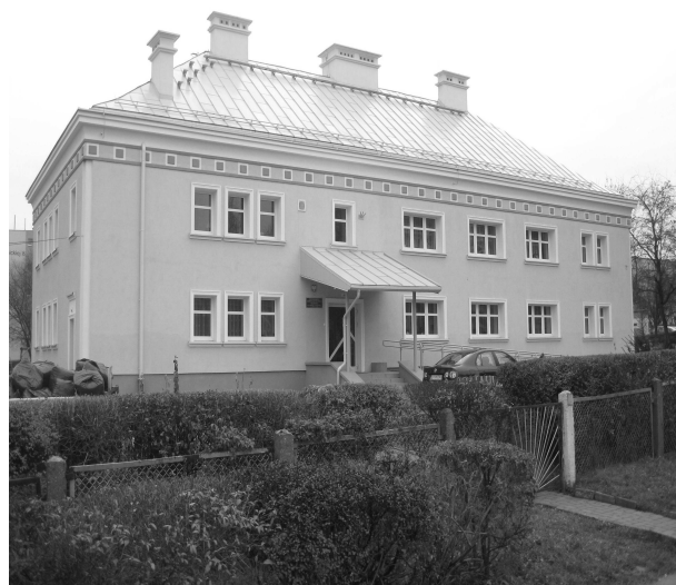
Rys. 3. Widok przedszkola po termomodernizacji
