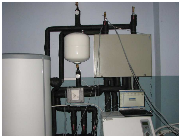
Rys. 2. Pompa ciepła FIGHTER 1140 z modułem klimatyzacyjnym HPAC, zasobnikiem ciepła oraz przeponowym naczyniem wzbiorczym (archiwum firmy HANDAN)
