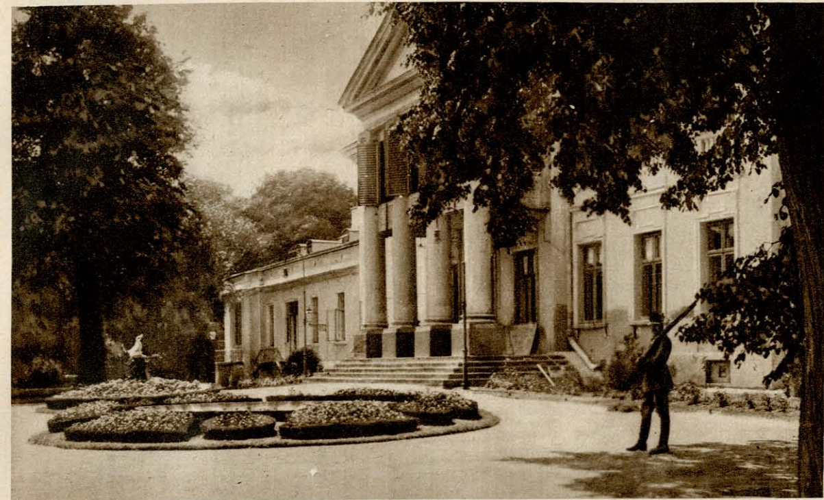
Belweder, siedziba Generalnego Inspektoratu sił zbrojnych.
