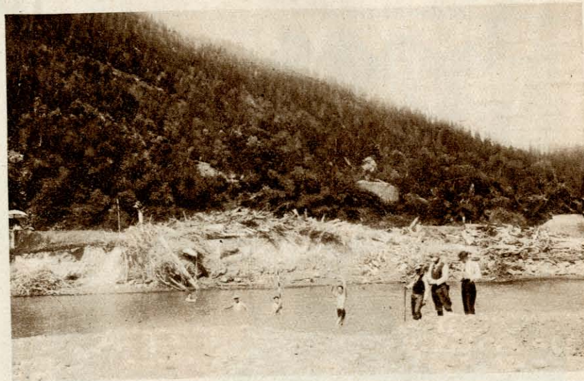
„Dogodne“ warunki pomiarowe nad Czeremoszem. Przeciąganie taśmy pomiarowej przez rzekę.
