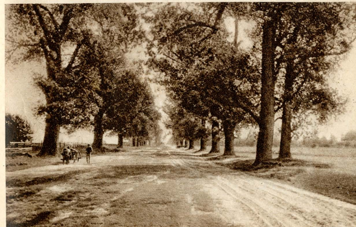
Typowy trakt poleski. Trakt piński, o szerokości 30 m, bez nawierzchni i bez żwiru.
