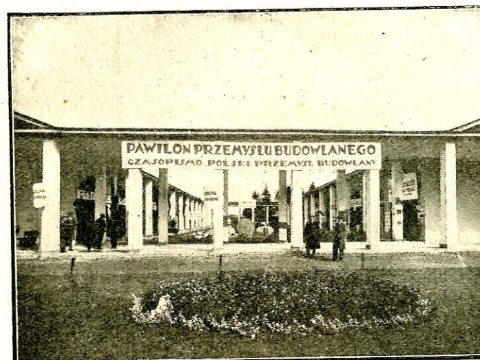
Lwów, Targi Wschodnie: Pawilon przemysłu budowlanego.
