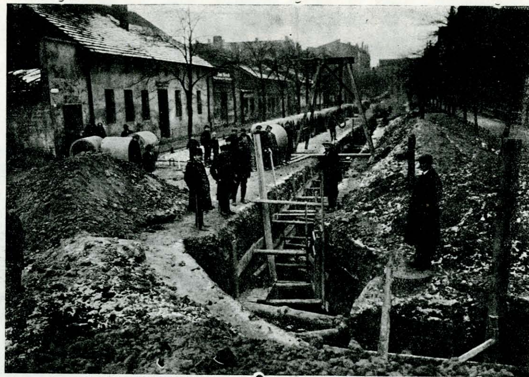
Królewska Huta: Roboty kanalizacyjne miejskie na ulicy Krzyżowej.
