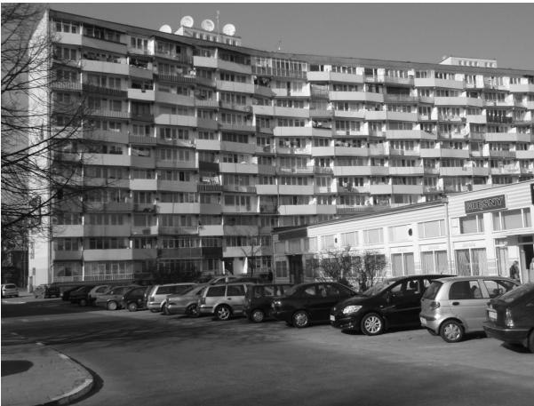
Ryc. 3. Parkingi zabudowy z lat sześćdziesiątych, Gdańsk - Przymorze (zdjęcie autora)
