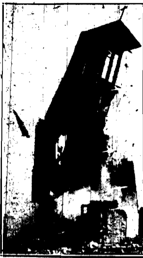
Stara wieża zrujnowana w Seattle. Kolo Waszyngtonu skazano na zagładę, gdyż wykonano budowę nowego kościoła kosztem 1.500.000 dolarów. Wieża owa pamiętała czas, gdy u jej stóp modlili się pierwsi mieszkańcy Seattle, opornie stawiała czoło niszczącym wybuchom dynamitu. Dopiero czwarty nabój zwał ją z podstaw.
