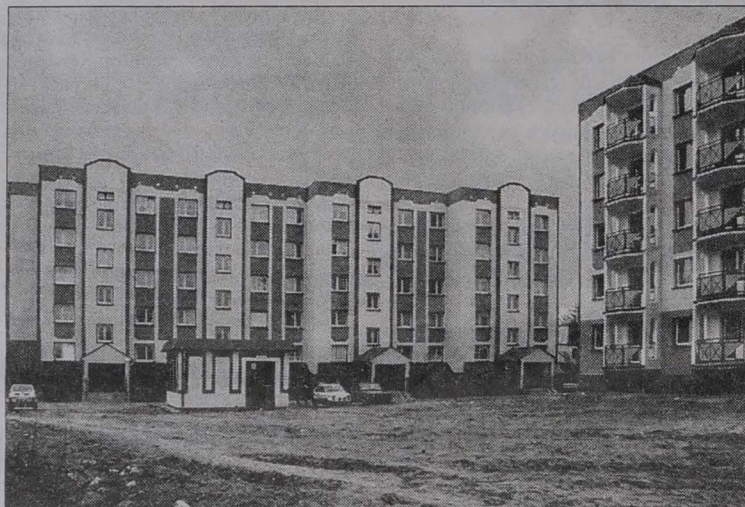
W lutym i wrześniu br., po 3 latach budowlanej śpiączki, Spółdzielnia Mieszkaniowa Lokatorsko-Własnościowa w Grajewie oddała do użytku 2 bloki, w których zamieszkały 64 rodziny. W październiku 1998 r. stanie 30-mieszkaniowy blok z 7 pawilonami handlowymi i 16 garażami (widoczny obok na zdjęciu). Jak zapewnił inż. Tadeusz Grygo – prezes firmy „Rober” realizującej całość inwestycji – budynek ten zgłoszono do konkursu „Mister Budownictwa 98”.
