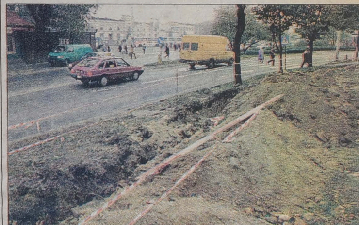
Wykopy pod nową instalację gazową przy ul. Kolejowej w Białymstoku
