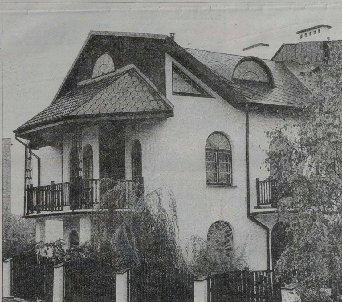
Efektowny, bogato rozbudowany dach, na jednym z białostockich budynków
