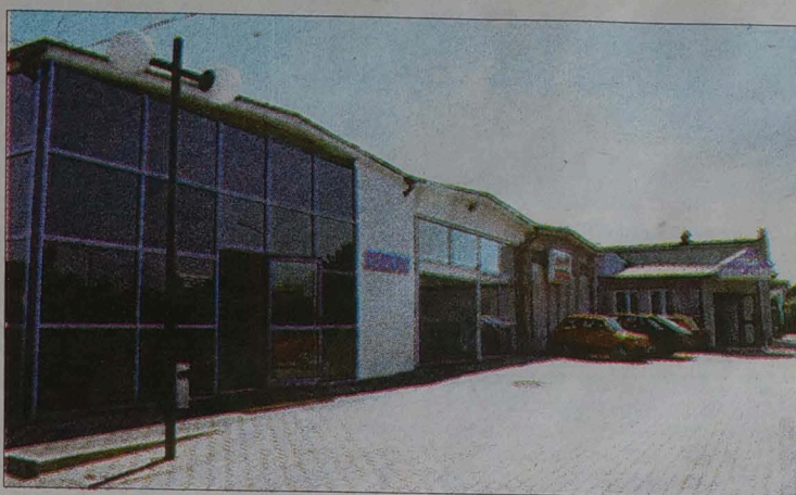
Na pierwszym planie stacja obsługi, z prawej wjazd na halę Stacji Kontroli Pojazdów. Po modernizacji całość tego obiektu sprawia bardzo korzystne wrażenie – to już europejski standard.
