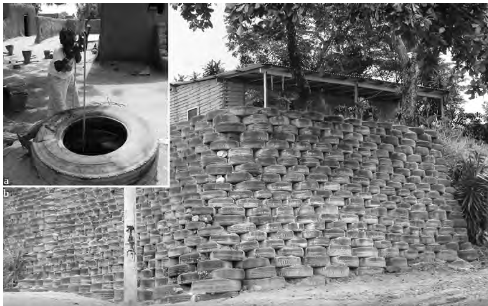
Ryc. 25. Stare opony jako cembrowina studni i konstrukcja skarpy
