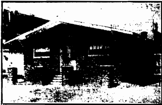
W W. Kentucky w Stanie Kentucky wybudowano dom całkowicie z węgla i cegły. Ogółem do budowy zużyto 25 ton węgla.
