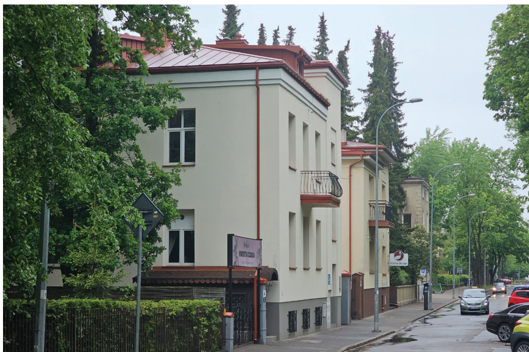
2. Zespół modernistycznych willi przy ul. Akademickiej 24, 26 i 26a, widok od strony plant w kierunku ul. Legionowej, stan obecny. Fot. W. Wróbel A complex of modernist villas at 24, 26, and 26a Akademicka Street, view from Planty park towards Legionowa Street, current state. Photo by W. Wróbel
