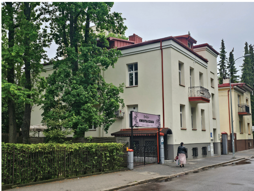
17. Willa przy ul. Akademickiej 26a – dom dr. Józefa Lewitta, stan obecny. Fot. W. Wróbel Villa at Akademicka Street 26a – Dr. Józef Lewitt's house, current state. Photo by W. Wróbel
