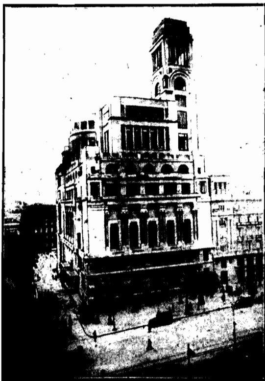
zbudowany został w Madrycie gmach na 100 kondygnacji, pensjów.
