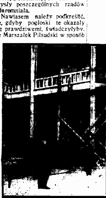
Przebudowa hoku w starym gmachu sejmowym.
