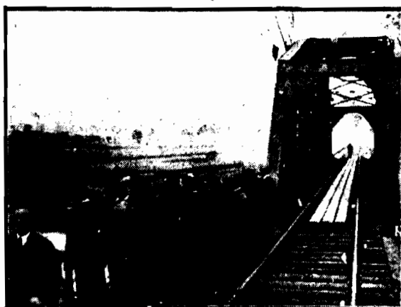
Nowa linja kolejowa Podzamcze — Kalety, która została zbudowana z rekordową szybkością, stoi również i pod względem technicznym na znacząco wyższym poziomie. Jest to linja typu magistralnego, solidna, może ona podolac najbardziej intensywnemu pasażerskiemu i towarowemu. Zbudowano na niej szereg mostów, z tych największy na rzece Prońce.
