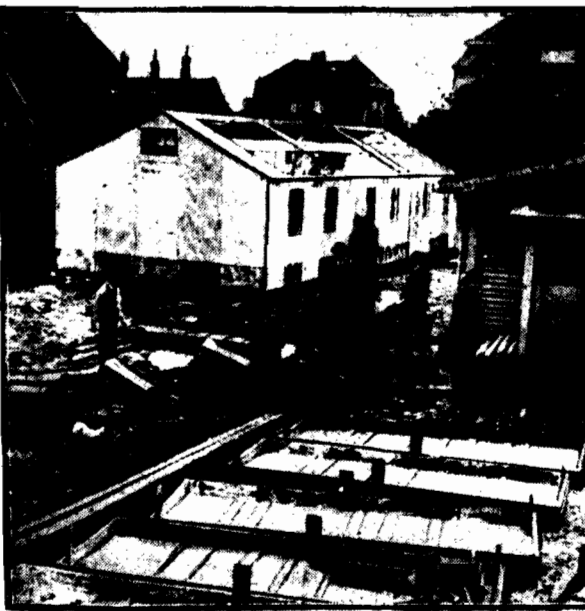
BUDOWA BARAKÓW w miejscowości... na przejęcie chorążych...
