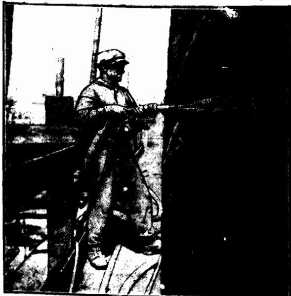
W BERLINIE po raz pierwszy zastosowano specjalną maszynę do szkafowania domów, wa-żną powierzchnią, która wymaga 4 tygodnie roboty ręcznej, może być od-szwiniarska w 10 dni maszyną.
