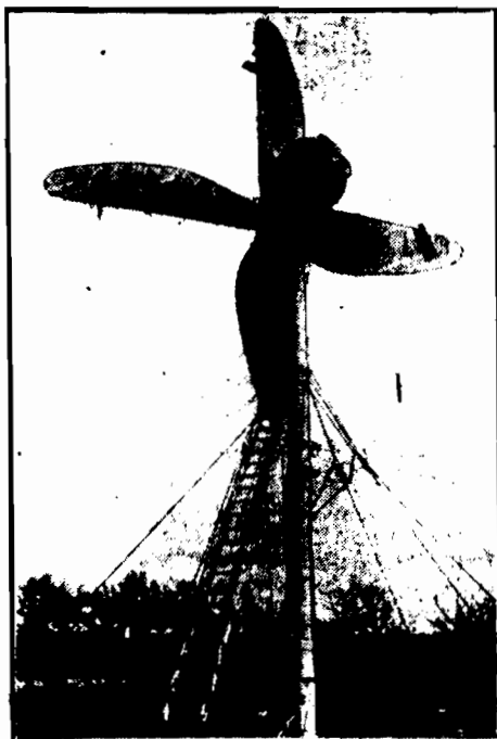
„Aero-Dynamo” do wytwarzania elektryczności przy pomocy wiatru.
