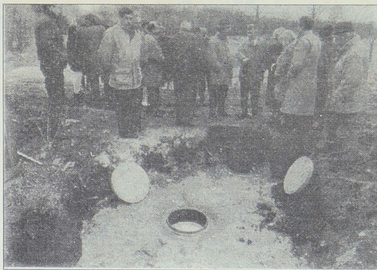
Otwór zbiornika gnilnego w przyzgodowej oczyszczalni ścieków.
