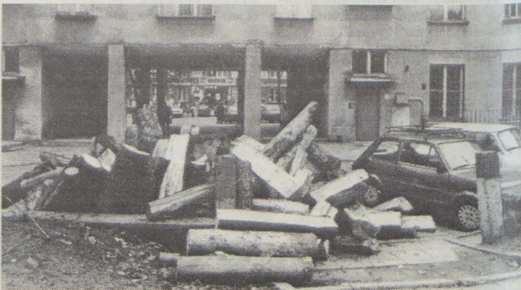
W czasie remontu dachów przy ul. Suraskiej „na podpalke” zużyto już pokazy stoś drewna Fot. M. Kość
