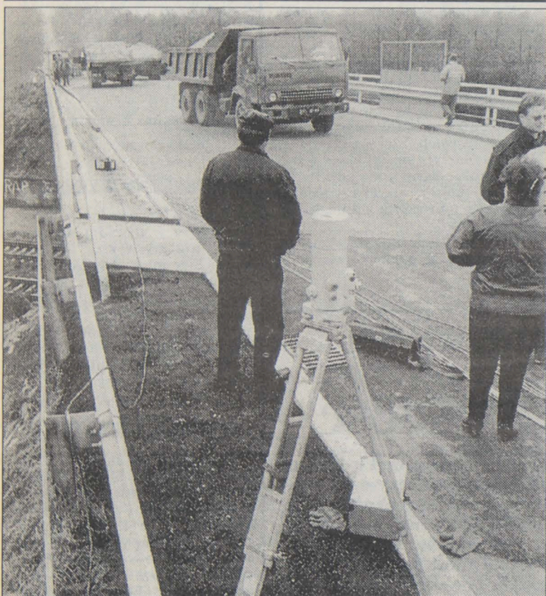
Próba obciążenia mostu na trasie Sokółka — Kuźnica
