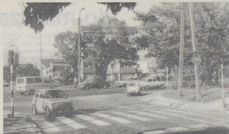
Wylot ul. Traugutta na Wasilkowską, zdaniem kierowców i pieszych — nie należy do bezpiecznych Fot. A. Zgiet
