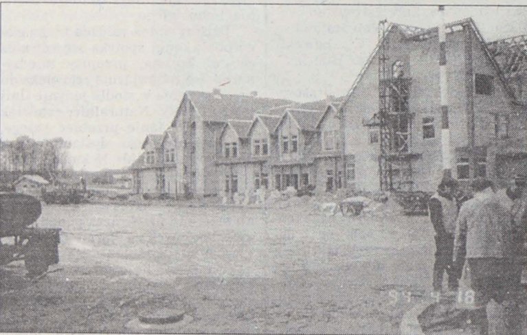
Budynek główny na przejściu granicznym w Budzisku.
