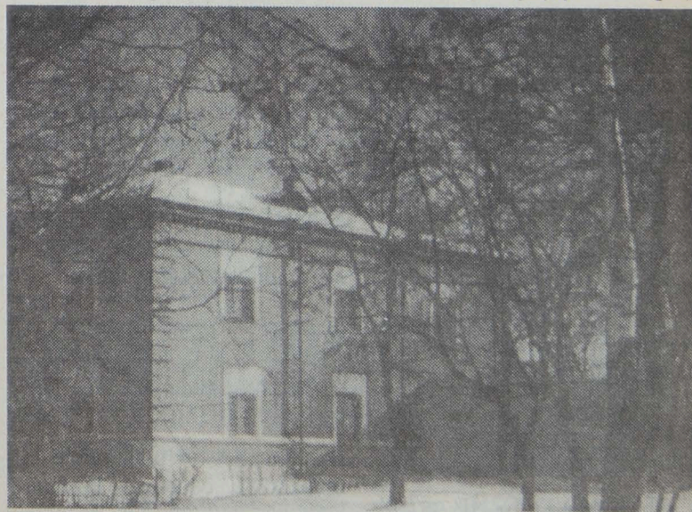
Budynek, w którym przed 20 laty miała swą siedzibę ostatnia jednostka Armii Radzieckiej w Białymstoku.
