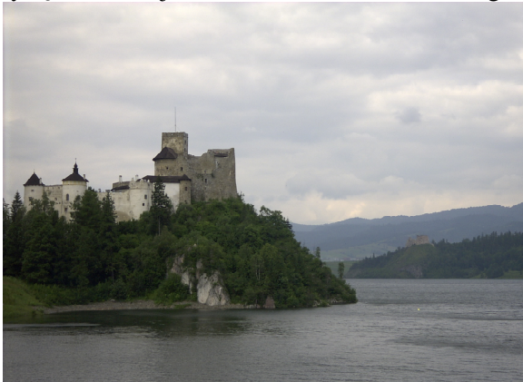
Rys. 1. Górny zbiornik elektrowni Nidzica-Sromowce
