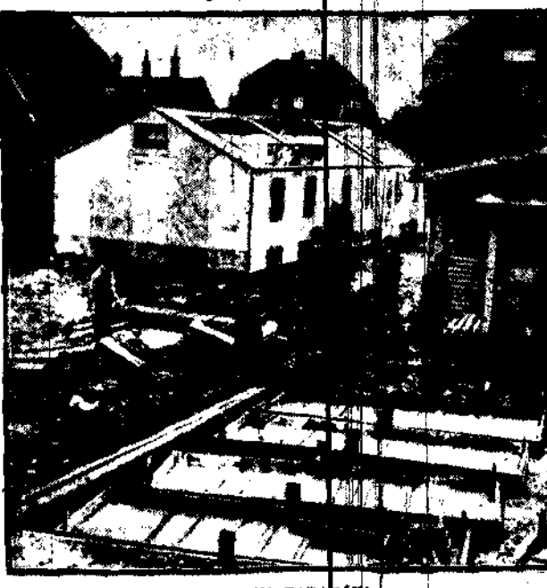
BUDOWA BARAKÓW w Hanowerze, na potrzeby choroby tyfusu.
