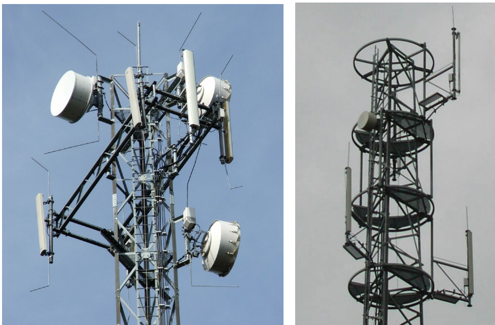
Rys. 3.1. Przykłady zwodów stosowanych do ochrony anten
