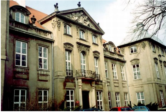
23. Korpus główny Pałacu Czapskich, widok od dziedzińca, stan przed remontem w 2004 r.
