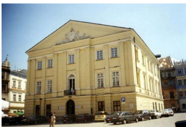
32. Klasycystyczny gmach Trybunału Koronnego w Lublinie, zastąpił stary drewniany Ratusz spalony w 1389 r., posiedzenia odbywały się na pierwszym piętrze budynku.
