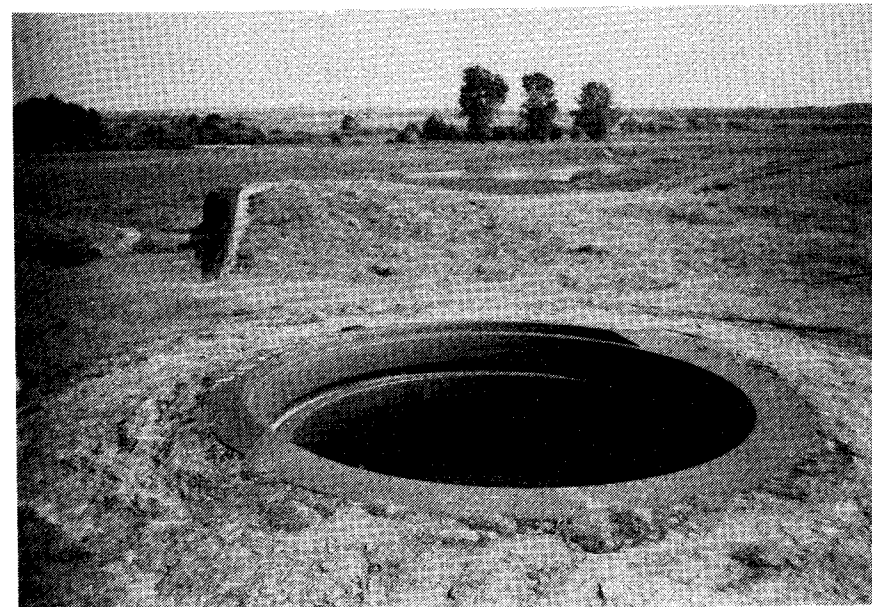
Obiekt nr 2. Przedpancerz wieży, na drugim planie półkopuła obserwacyjna
