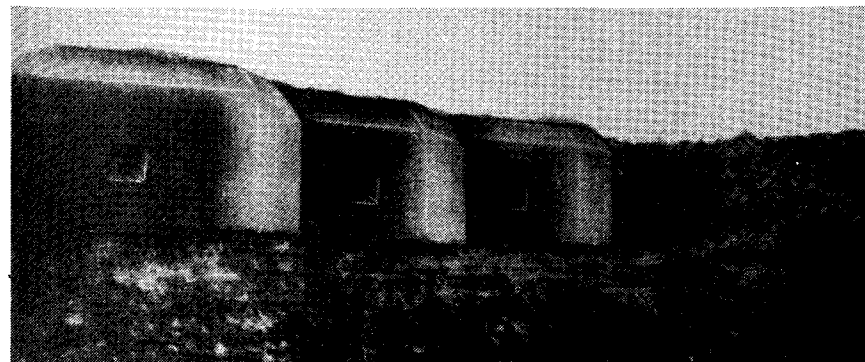
Obiekt nr 5 - tradytory artyleryjski lewego barku Fortu II. (fot. arch. sprzed 1939 r.)
